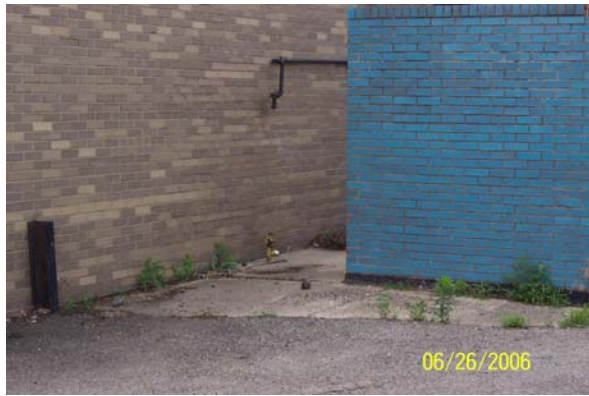
NC 20A – UST Fill Pipe
